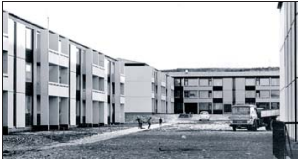
Efri mynd: „Langavitleysa“ í byggingu. Neðri mynd: Fjölbýlishús í Fellahverfi.
